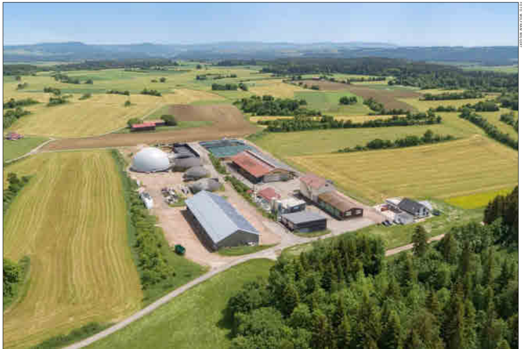
Der Haslachhof in Löffingen im Hochschwarzwald hat ein Gesamtkonzept, mit Rindern, Bio-Ackerbau und Energieerzeugung.
